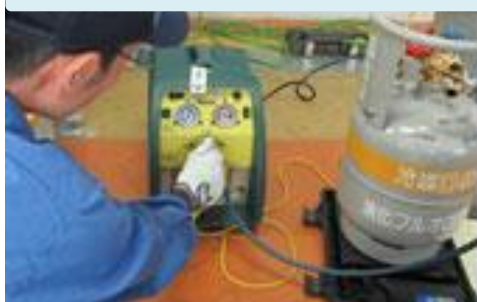
冷媒回収作業
