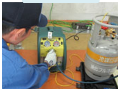
冷媒回収作業
